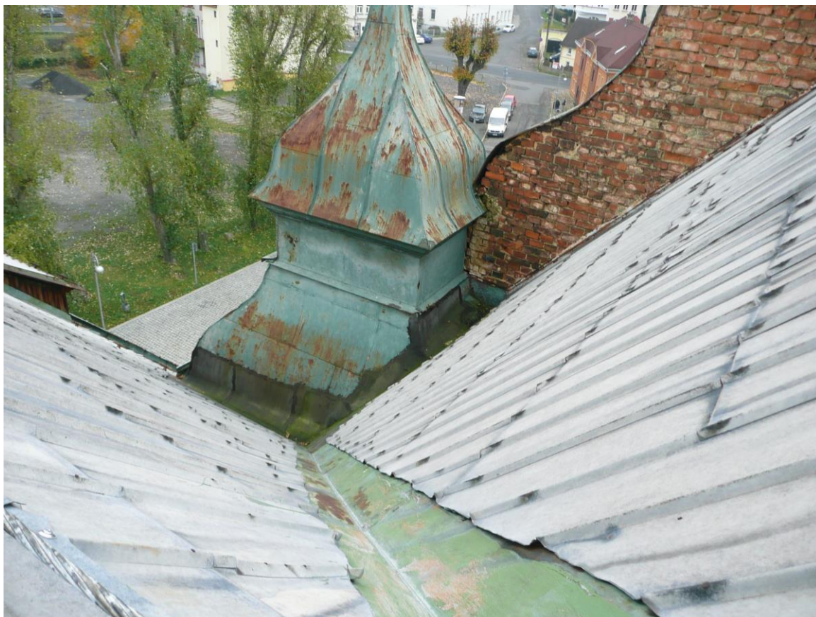
Úžlabí utěsněné asfaltovými pásy
