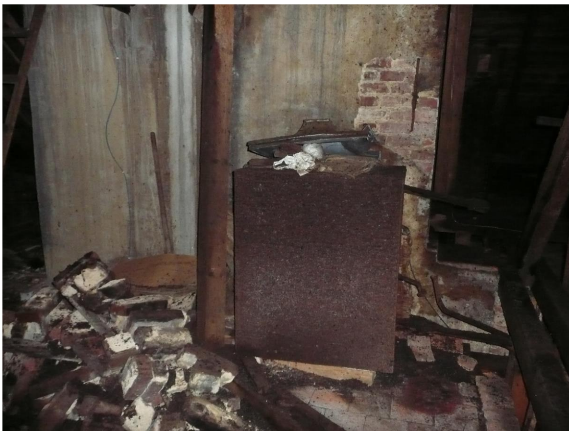
Nefunkční expanzní nádrž a hromada cihel z ubouraného komína zatěžující strop půdy
