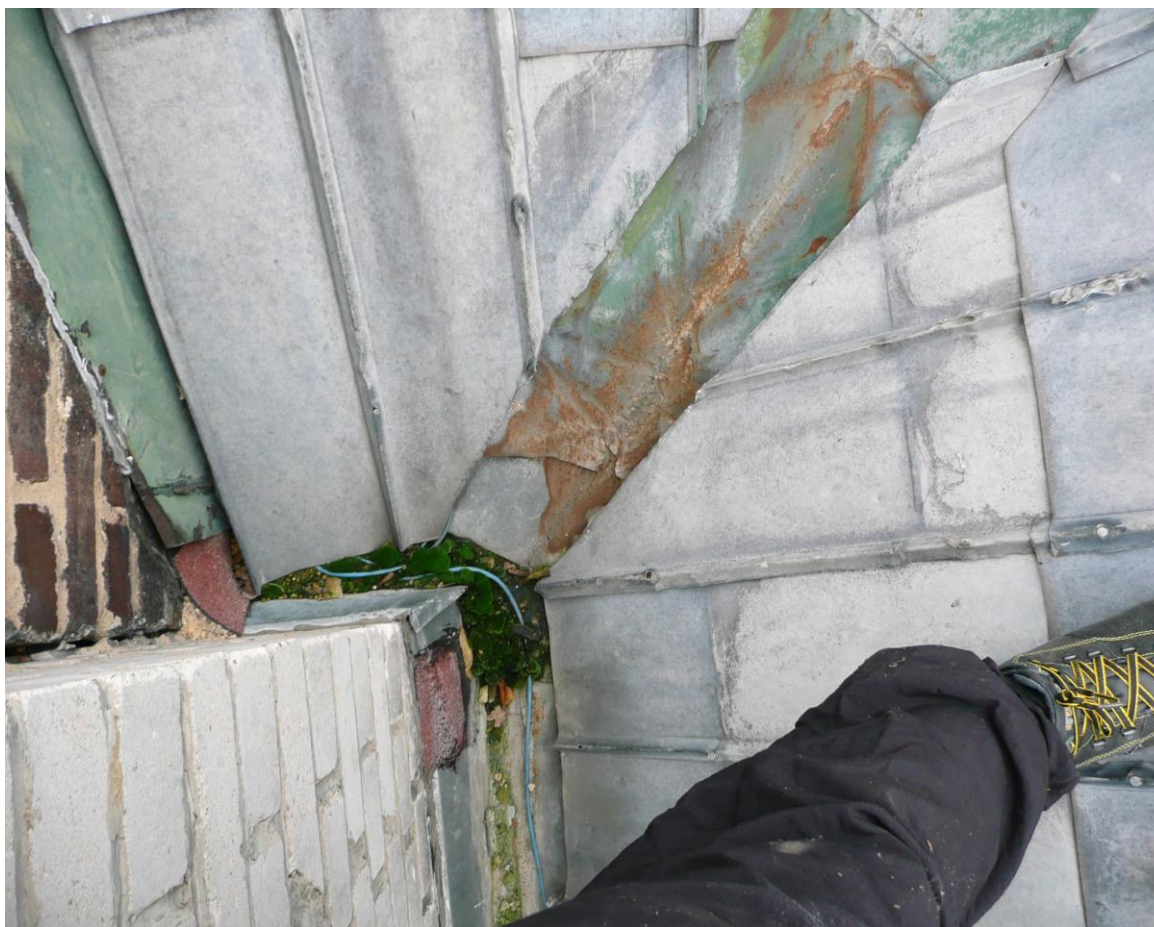
Vyspráva úžlabí a oplechování komína záplatou z asfaltových pásů, rezavý úžlabní plech
