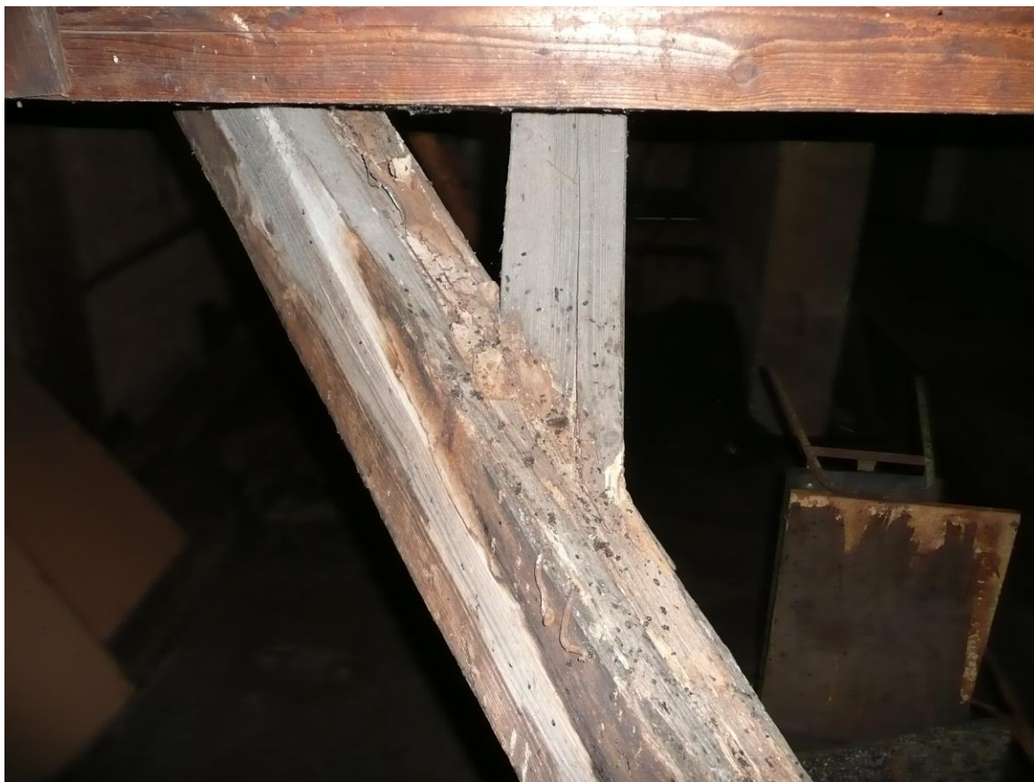
Poškození úžlabní a navazující krokve dřevokaznou houbou
