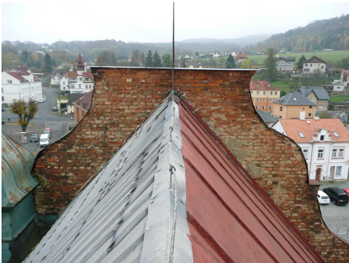
Vnitřní nadstřešní zdivo štítů zbavené vlivem povětrnostních vlivů omítky
