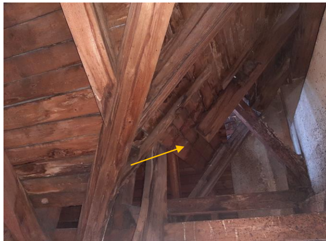
Obr. č.4. Bednění střechy u vletového otvoru, jenž je překážkou pro netopýry, a mohlo by se zredukovat.
