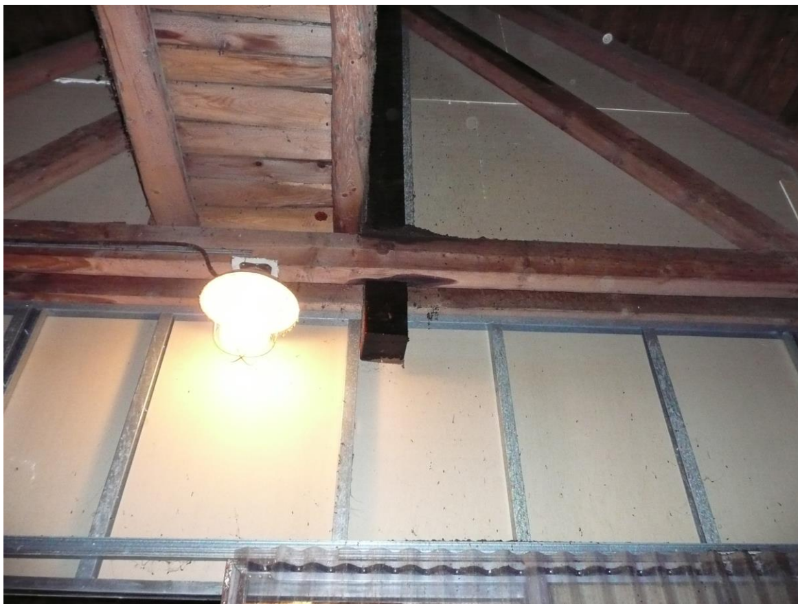
Tekutina stékající po dřevěných prvcích krovu z vrstvy netopýřího trusu
