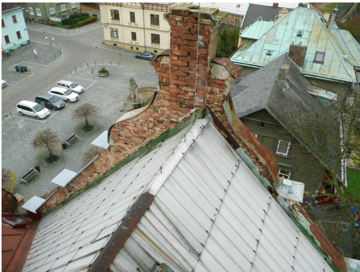
Poškození komínového zdiva ve vrcholu štítu
